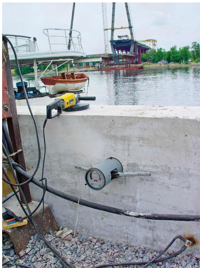
Определение водонепроницаемости бетона методом воздухопроницаемости по образцам и непосредственно в конструкции на объекте прибором АГАМА-2Р
