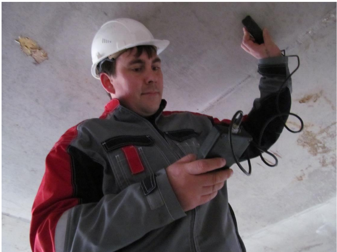
Определение нахождения арматуры, её диаметра, защитного слоя бетона в конструкции в монолитной железобетонной плите перекрытия прибором ИПА-МГ4.01
