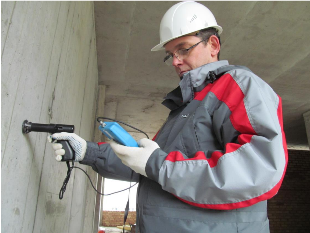
Определение прочности бетона в монолитной железобетонной стене неразрушающим механическим методом (методом ударного импульса) прибором ИПС-МГ4
