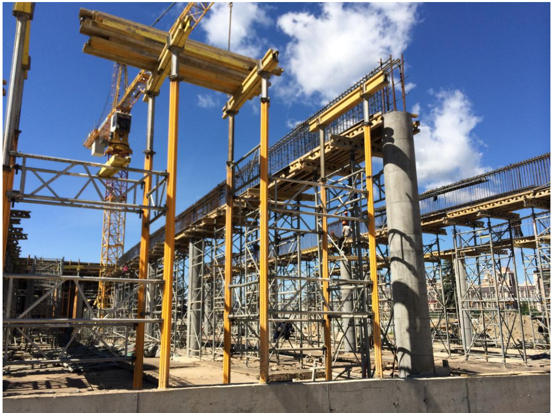
Монтаж элементов опалубки для устройства монолитного железобетонного перекрытия
